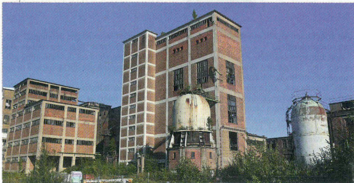
Mit der Sanierung der alten Papierfabrik kommt viel Arbeit auf Prinz von Preussen zu. Quelle: Immobilien Zeitung, Urheber: Lars Wiederhold
