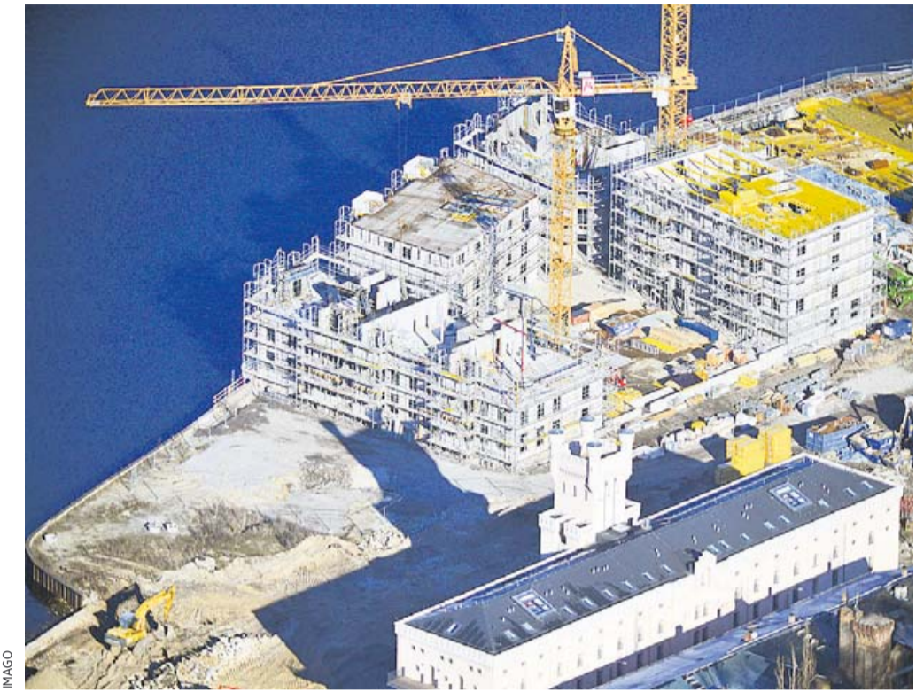
Baustelle der „Speicherstadt“: Auf einer ehemaligen Gewerbebrache in der Nähe des Hauptbahnhofs entsteht ein Quartier aus sanierten Speichergebäuden und Neubauten.
