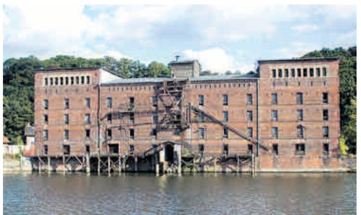
Vergangenheit So sah der Speicher vor Sanierung und Umnutzung aus. Über Jahre gehörte der Bau zu Potsdams eher finsternen Ecken
