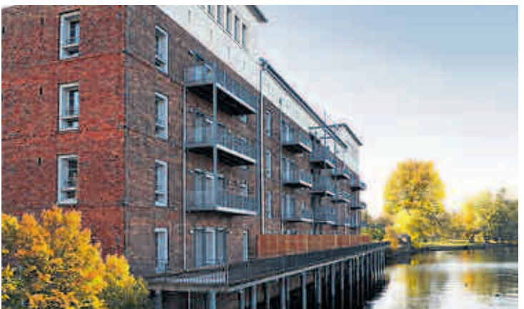
Erfolgreiche Sanierung In einem weiteren Speicher, Kasernen und dem ehemaligen Offizierskasino entstand besonderer Wohnraum
